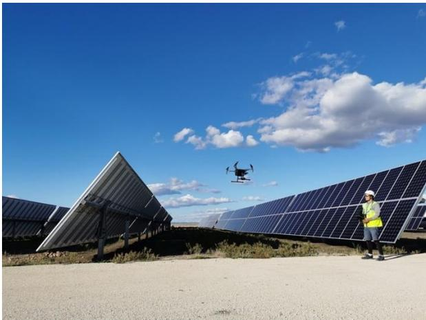
*BU: Volateqs Lösung ermöglicht drohnengestützte Checks von Solarfeldern durch intelligente Bildanalyse*
